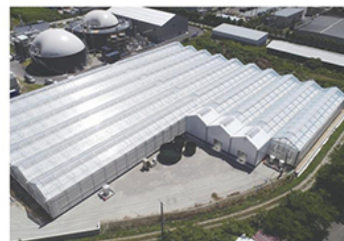
トーヨーバイオメタンガス発電所(写真奥)とハウス
